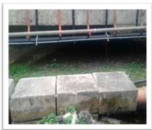
Tipičan primjer nepravilnog postavljanja instalacija kroz korita potoka i začepljenje zacjevljenog dijela kanala
