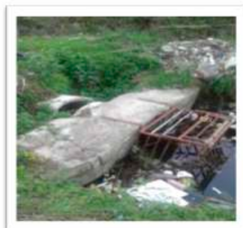
Tipičan primjer nepravilnog postavljanja instalacija kroz korita potoka i začepljenje zacjevljenog dijela kanala
