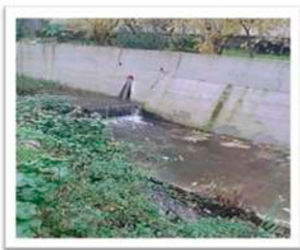
Takođe, tipičan primjer nepravilnog polovičnog ulaganja u sređivanje korita potoka i ispuštanje fekalnih voda u potok
