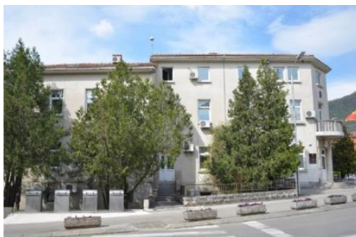
Slika 10: Stara zgrada Opštine
