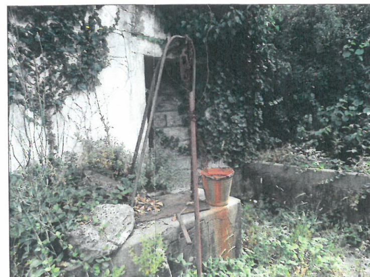
foto: terasa izmjeđu objekata 1 i 2
