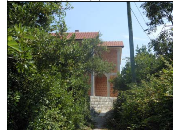
foto: prilaz objektu
