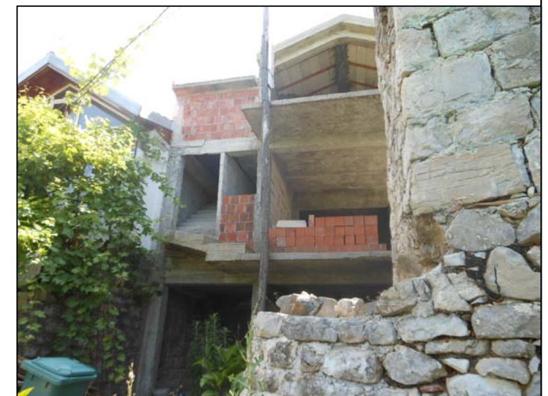
foto: objekat 2 (rušenje)
