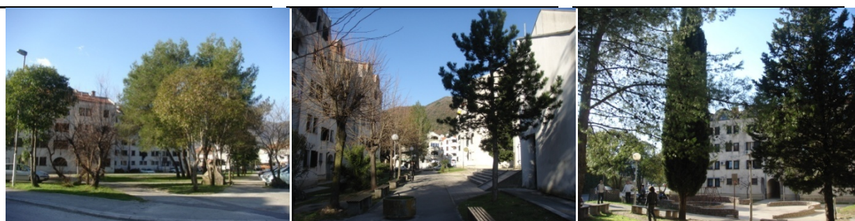
centralni dio lokacije sa kolektivnim stambenim objektima
