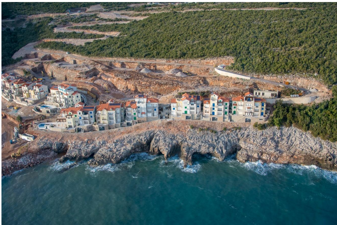
Slika 2.4. Izgled lokacije projekta
