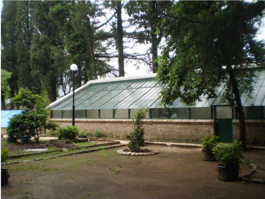
Slika 56. Izgled obnovljenog staklenika
