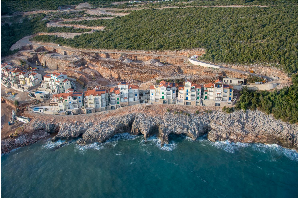
Slika 2.3. Izgled lokacije projekta
