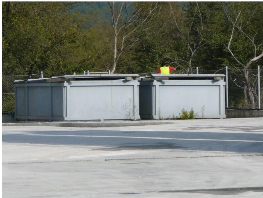
**Slika 8. Izgled rezervoara za vodu potrebnu za rad betonjerke**
