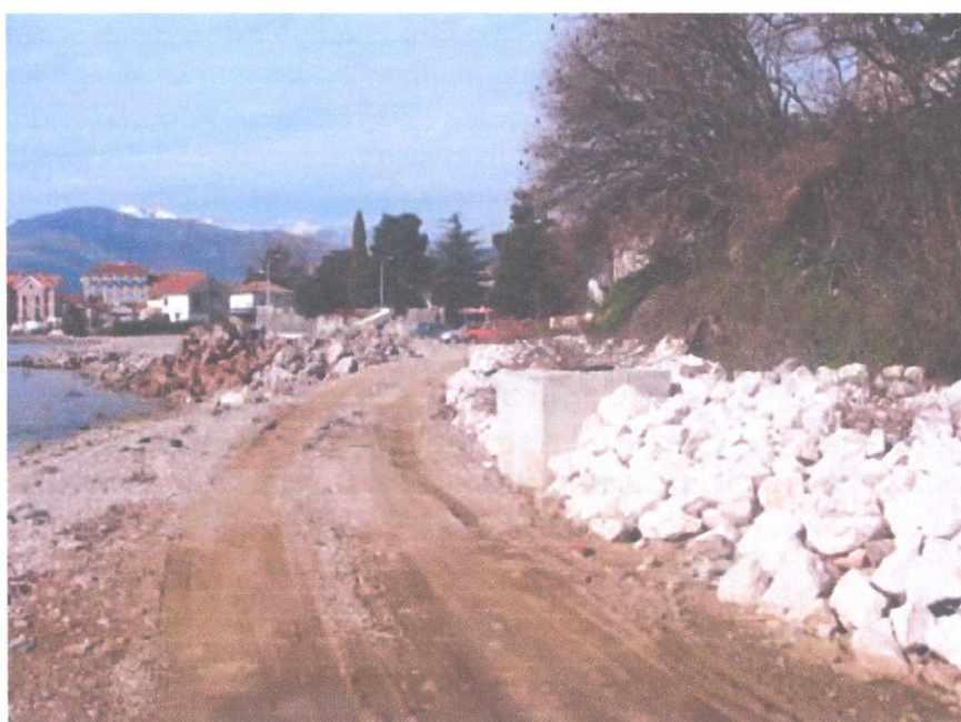
Slika 2.2/4. Dio na kojem je izvedena fekalna kanalizacija
